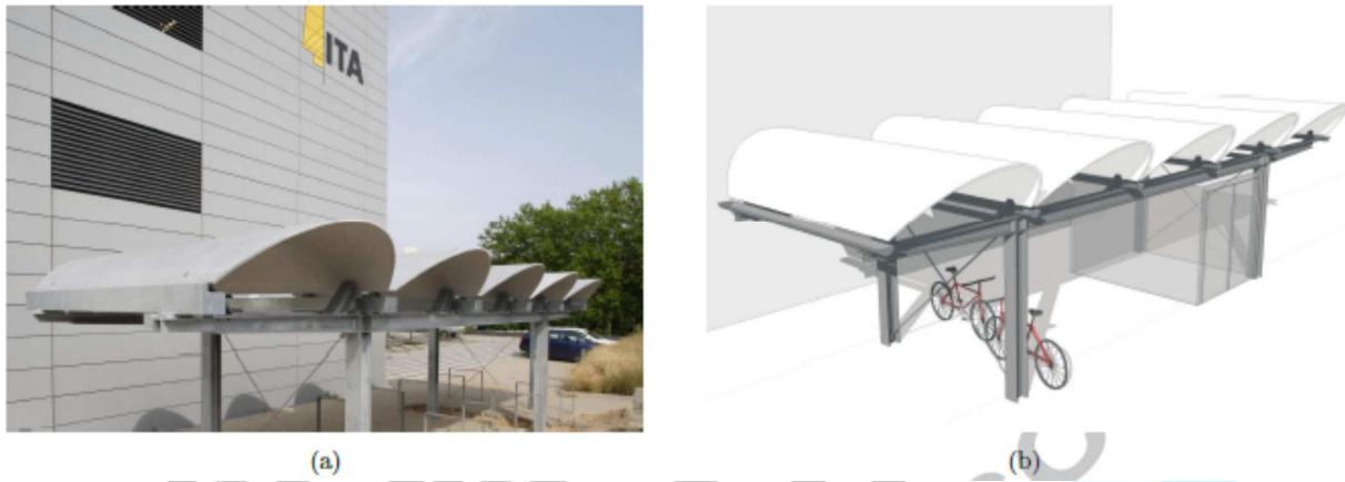
شکل 1: (الف) پوسته های طاق TRC به عنوان اجزای سقف. (ب) پایه دوچرخه شامل پنج پوسته منحنی است.
