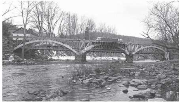
شکل ۱۸,۵ ابر سازه ای که از چوب درخت های کاج جنوبی فرآوری شده با فشار ، ایجاد شده است.
