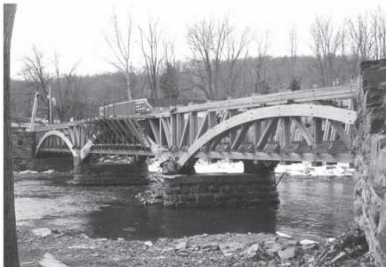
شکل ۱۸,۱ قنات شامل سه دهانه ی معادل به اندازه ی ۶۶ فوت
