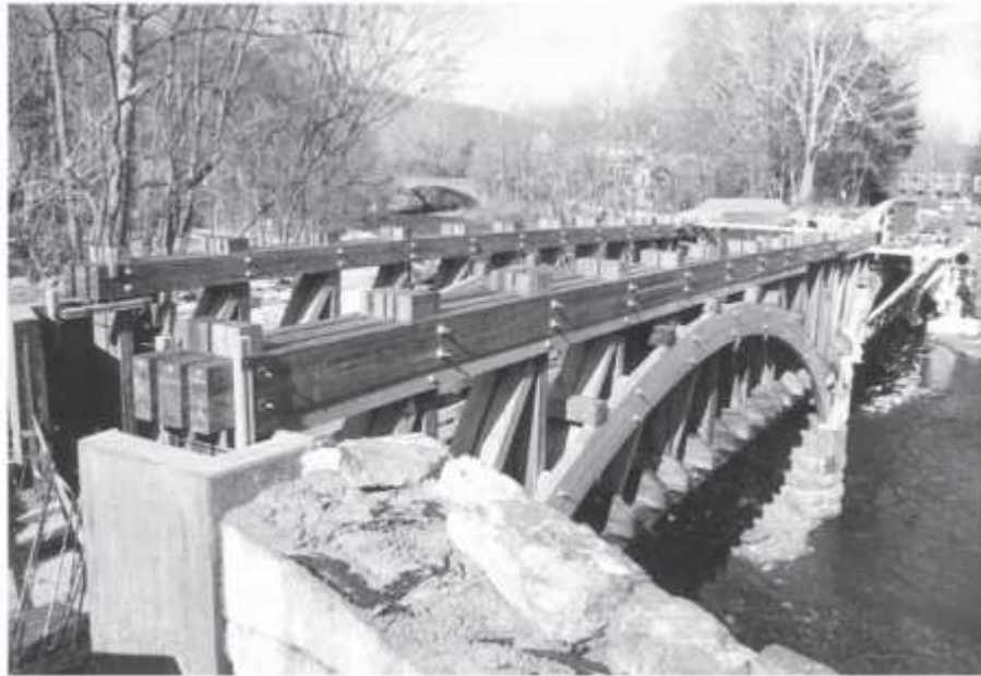
شکل ۱۸,۳ ساختار اریب دارای ۲۰۱ فوت و ۱۰ اینچ طول دارد.
