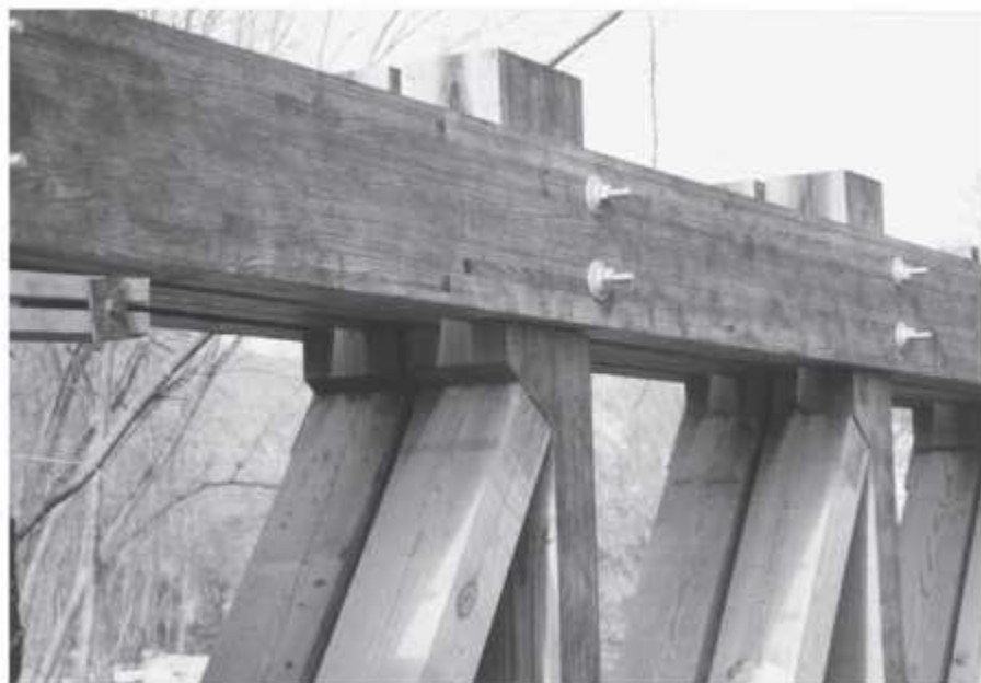
شکل ۱۸,۴ ریسمان ها از نوع الوار لمینت شده با چسب و فرآوری شده با فشار میباشد.
