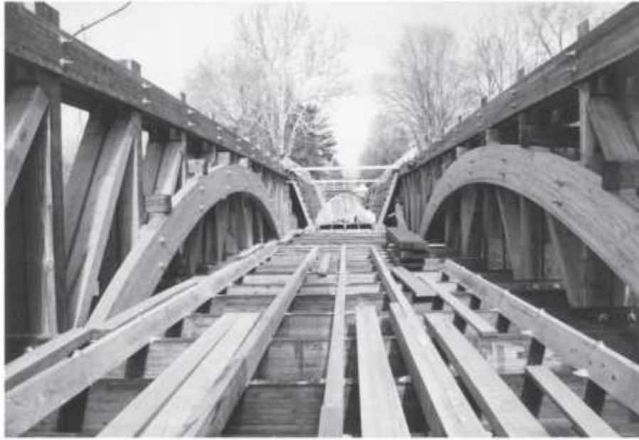
شکل ۱۸,۲ قوس ها از طریق مهندسی ارزشی توسط الوار لمینت شده توسط چسب ، جایگزین شدند.
