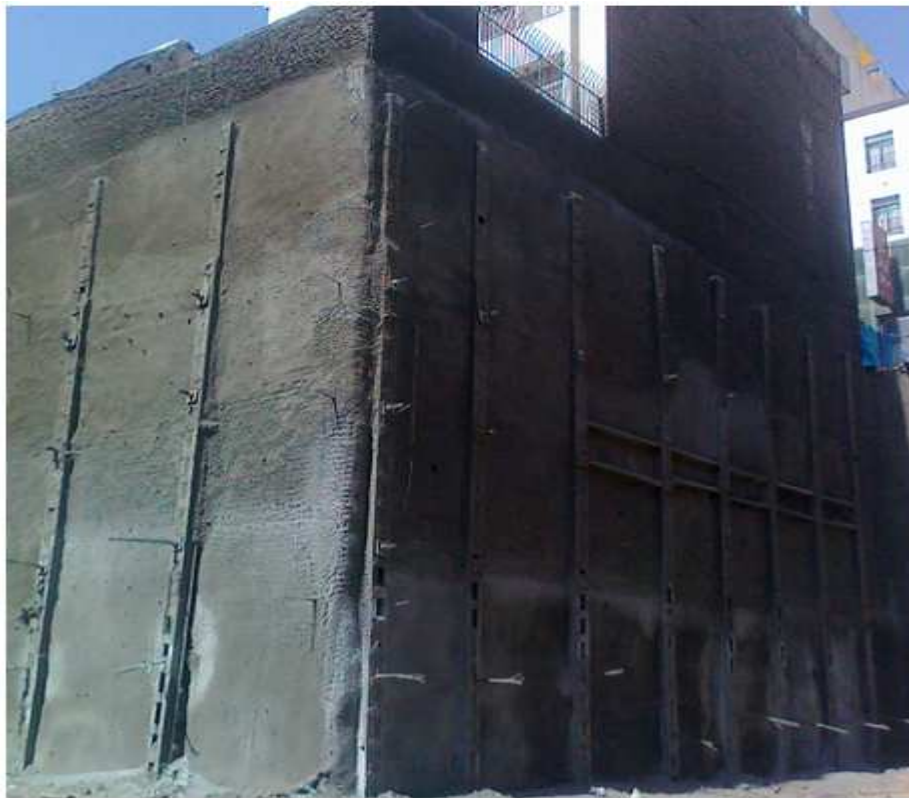
شکل 4: یک نمای سیستمی از سازه میخ کوبی خاک با ارتفاع 13 متر در سمت شرقی پروژه
