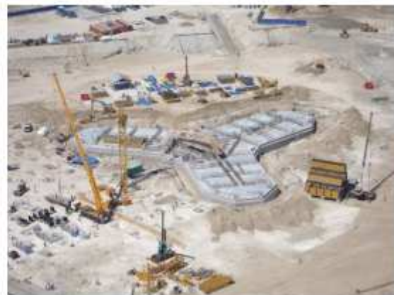
شکل 6: پلان فونداسیون برج و تصویری از ساخت پی متکی بر شمع
