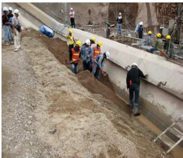
شکل 10: نصب کابل سنجش دمای توزیعی در سطح پایه سد
