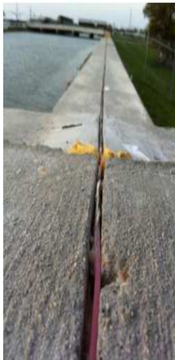
شکل 16: نصب حسگر SMARTprofile در یک شیار بر روی بالای مقطع دیواره خاکریز
