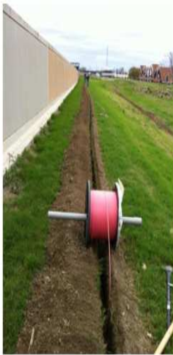
شکل 15: نصب حسگر SMARTprofile در ترانشه بر روی قسمت حفاظت شده خاکریز
