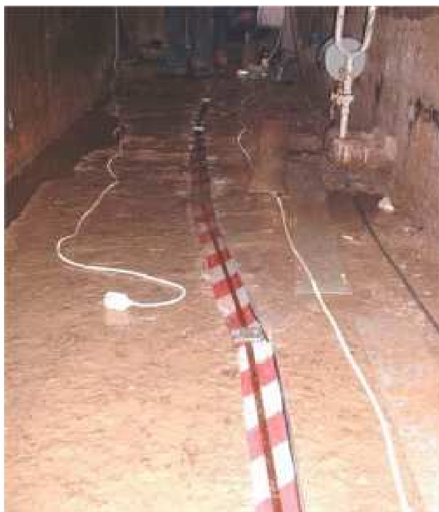
شکل 14: نصب SMARTape و کابل سنجش دما
