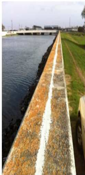
شکل 16: نصب حسگر SMARTprofile در یک شیار بر روی بالای مقطع دیواره خاکریز
