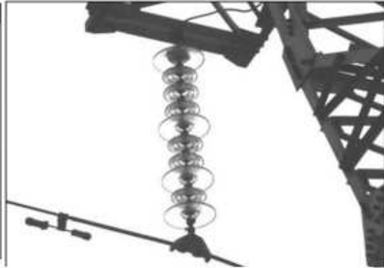
شکل 2. افزایش فاصله Shed To Shed در خطوط انتقال و توزیع 110 کیلوولت شبکه Guangdong
