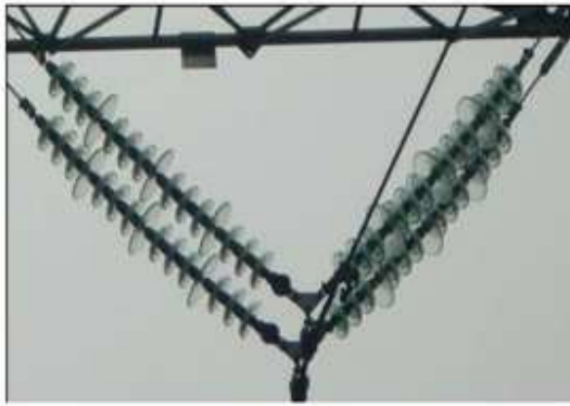
شکل 3. تغییر جهت یابی ایزولاتورها در خطوط انتقال و توزیع 220 کیلوولت شبکه Guangdong
