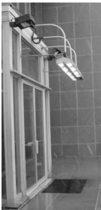
تصویر 10. سیستم ضد یخ مادون قرمز، حفاظت کننده در برابر ورود CRREL. (با تشکر از نویسنده)
